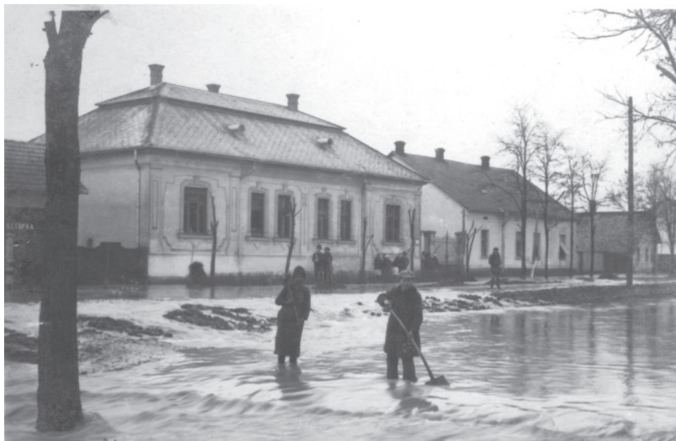
Casa avocatului Lazăr – inundații din 1925
