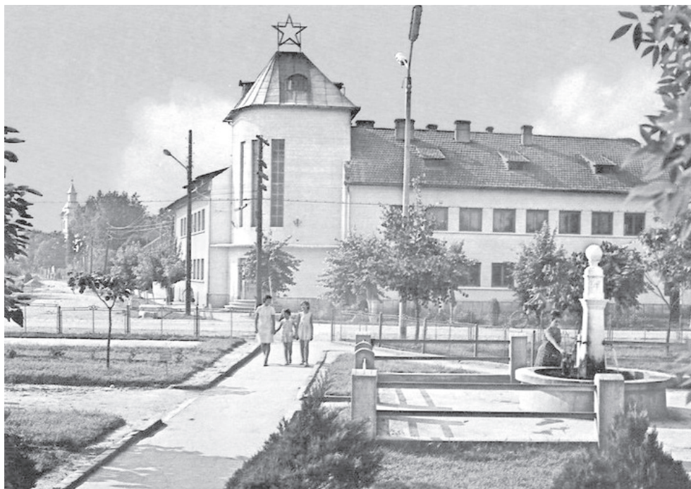
Fântâna arteziană (artezia) și clădirea spitalului vechi
